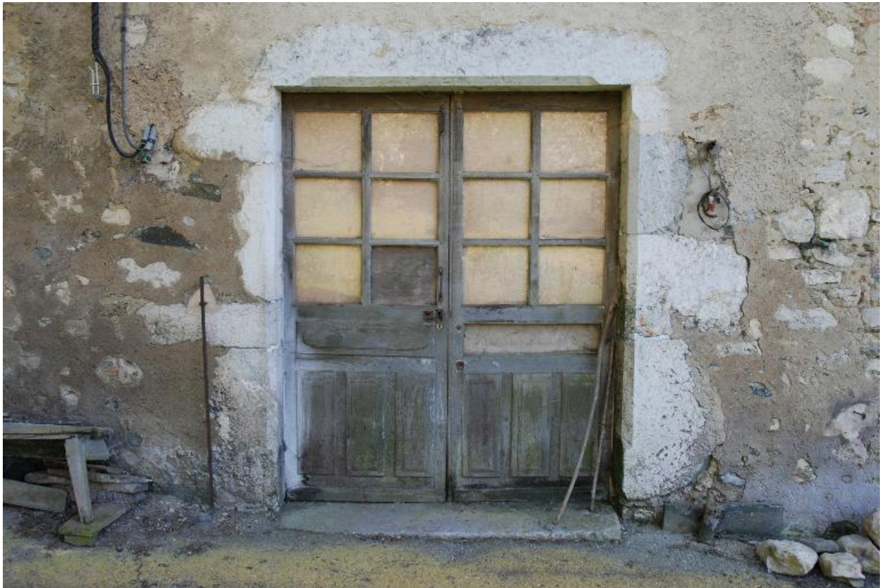
Détail de la double porte du rez-de-chaussée, façade avant.
