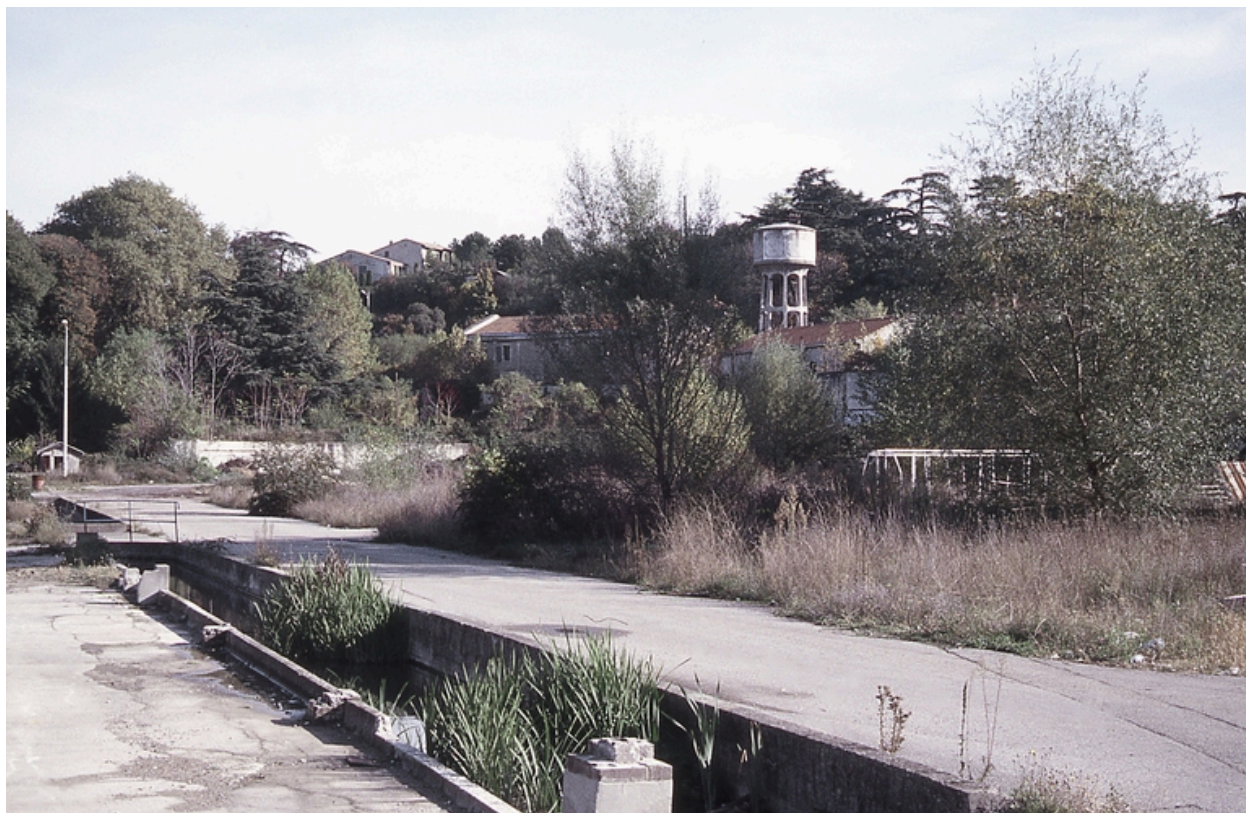
vue d'ensemble sud-est, canal et château d'eau
