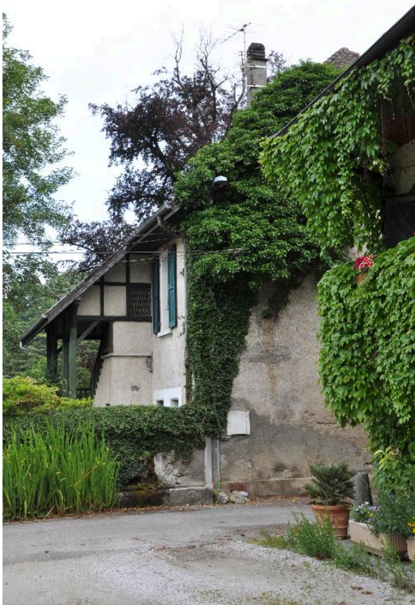
Vue sur l'escalier extérieur depuis l'est
