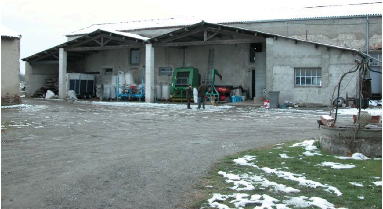
Vue de la grange-étable, depuis la cour.
