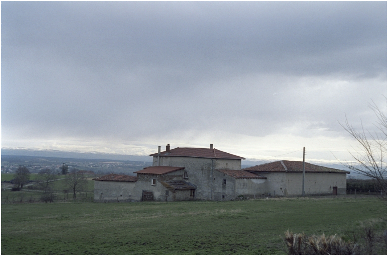
Trelins, le Clos (1986 B2 482-484), type C1. Vue générale depuis la route, de l'ouest (élévation postérieure des bâtiments).
