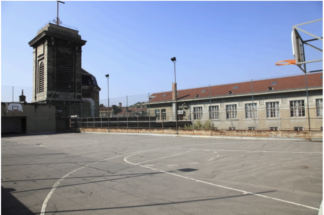
Terrasse sur le bâtiment sud.
