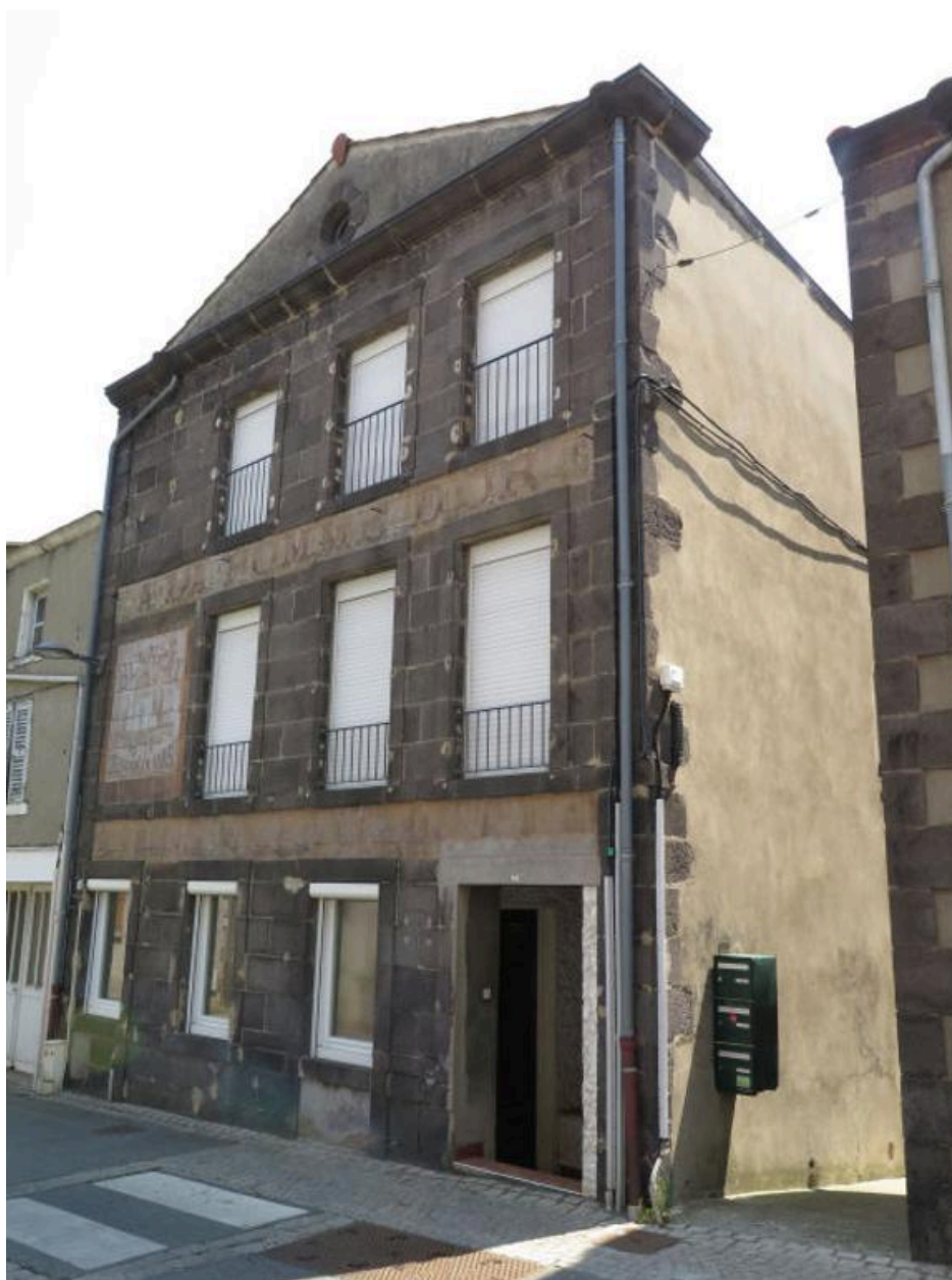
Vue générale des façades principale et latérale
