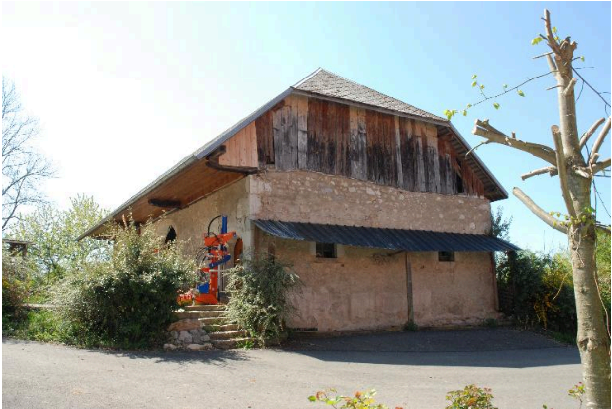
Vue d'ensemble de trois quart avant droit de la grange-étable.
