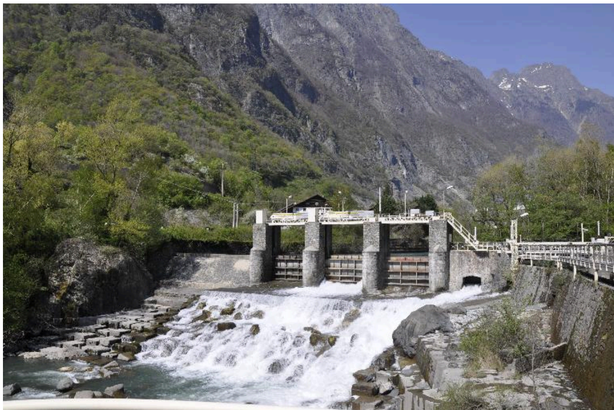
Vue du barrage
