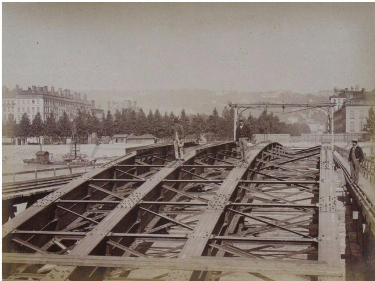
[Construction du pont du Midi : montage de la 1/2 travée amont rive gauche] / Fabrègue et Tardy phot., [juillet 1890]. 1 fotogr. pos. : n. et b. (AM Lyon. 2 Ph 00278, n°21)
