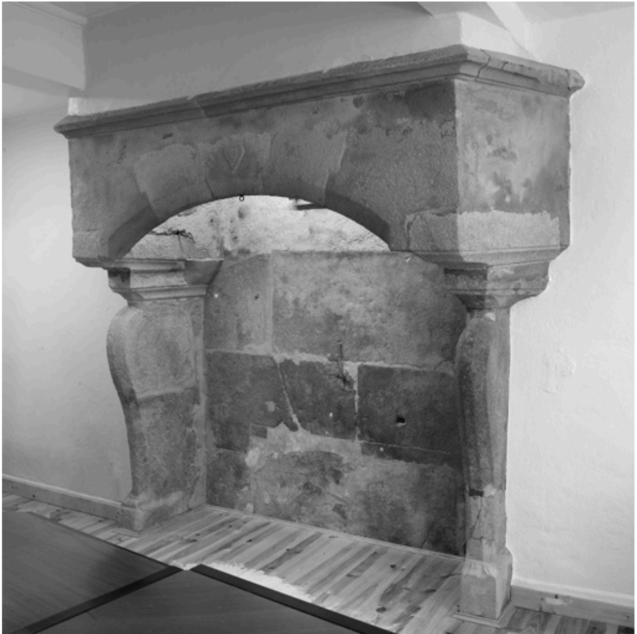
Cheminée de l'ancienne cuisine.
