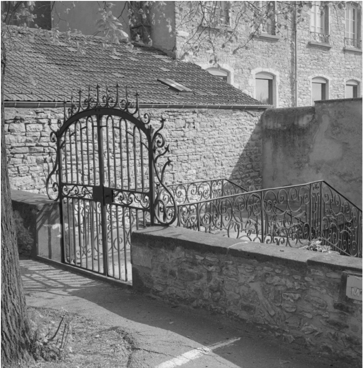
Portail et rampe en fer forgé de l'escalier extérieur isolé.
