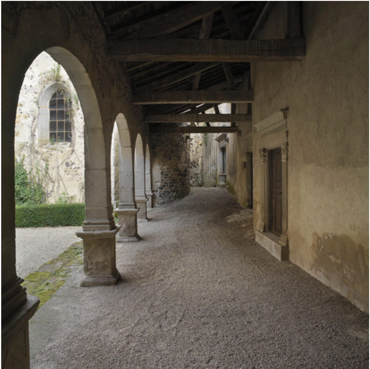
Vue intérieure de la galerie située devant l'aile est, depuis le sud.
