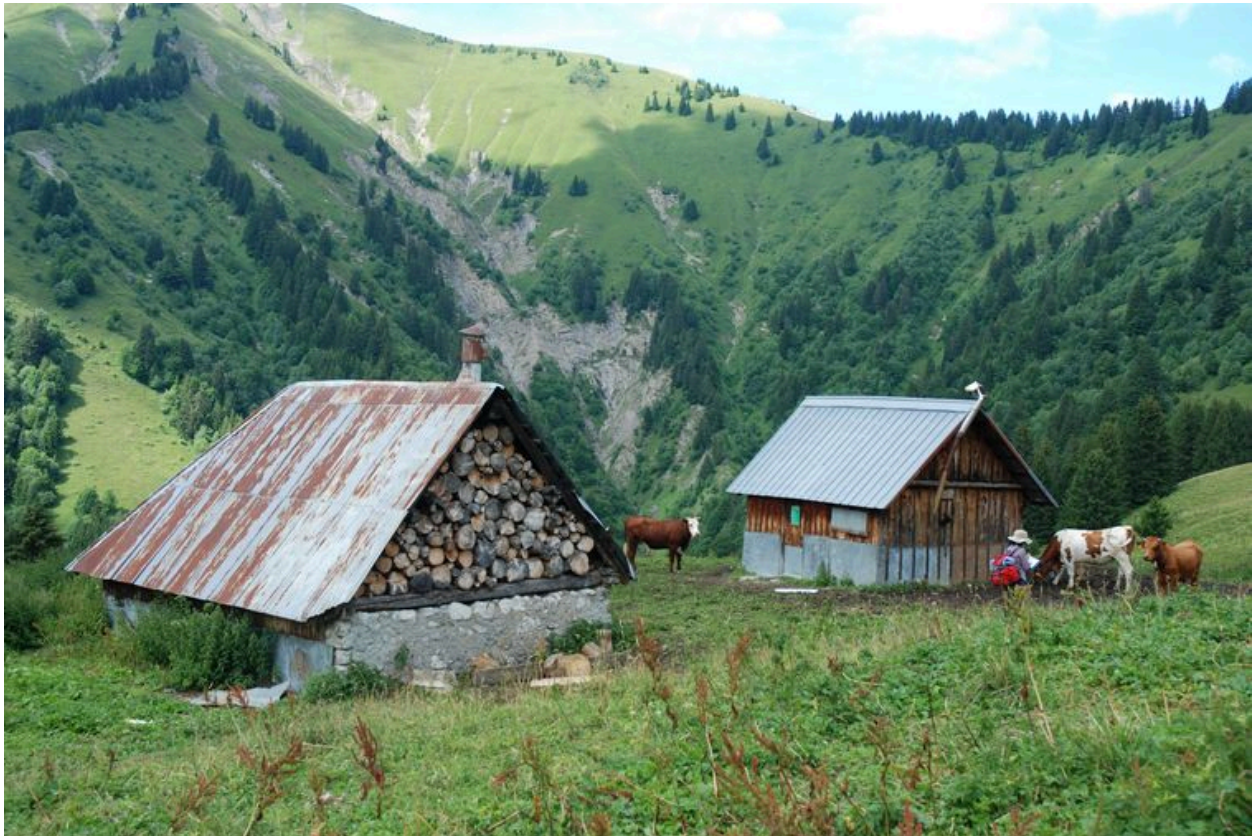
Vue du bâtiment d'habitation et du bâtiment de fabrication.
