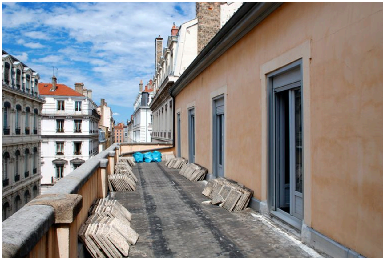
Elévation antérieure, vue de la terrasse, quatrième étage.
