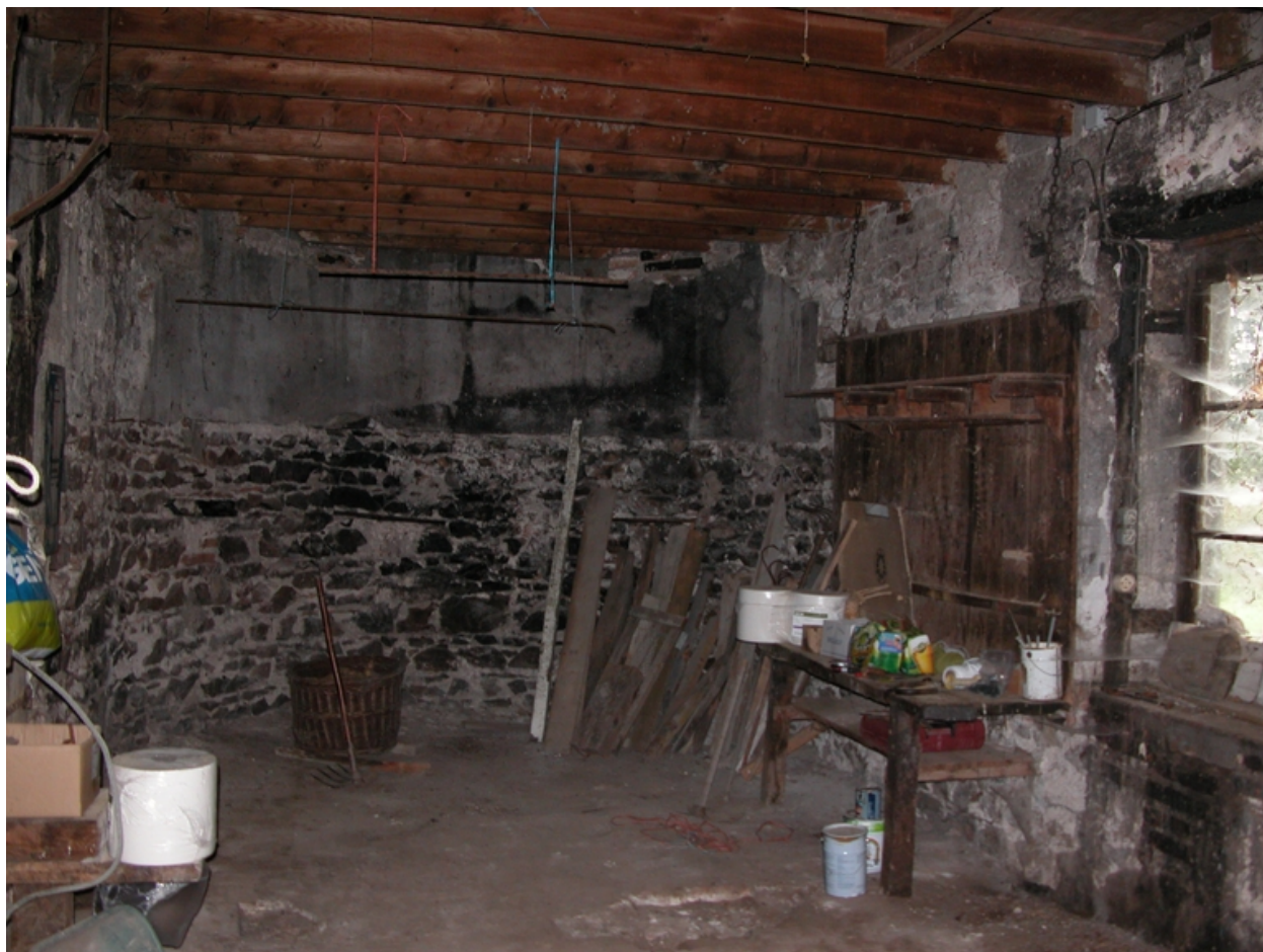
Vue intérieure du corps de bâtiment sud terminé en saillie de plan semi-circulaire.
