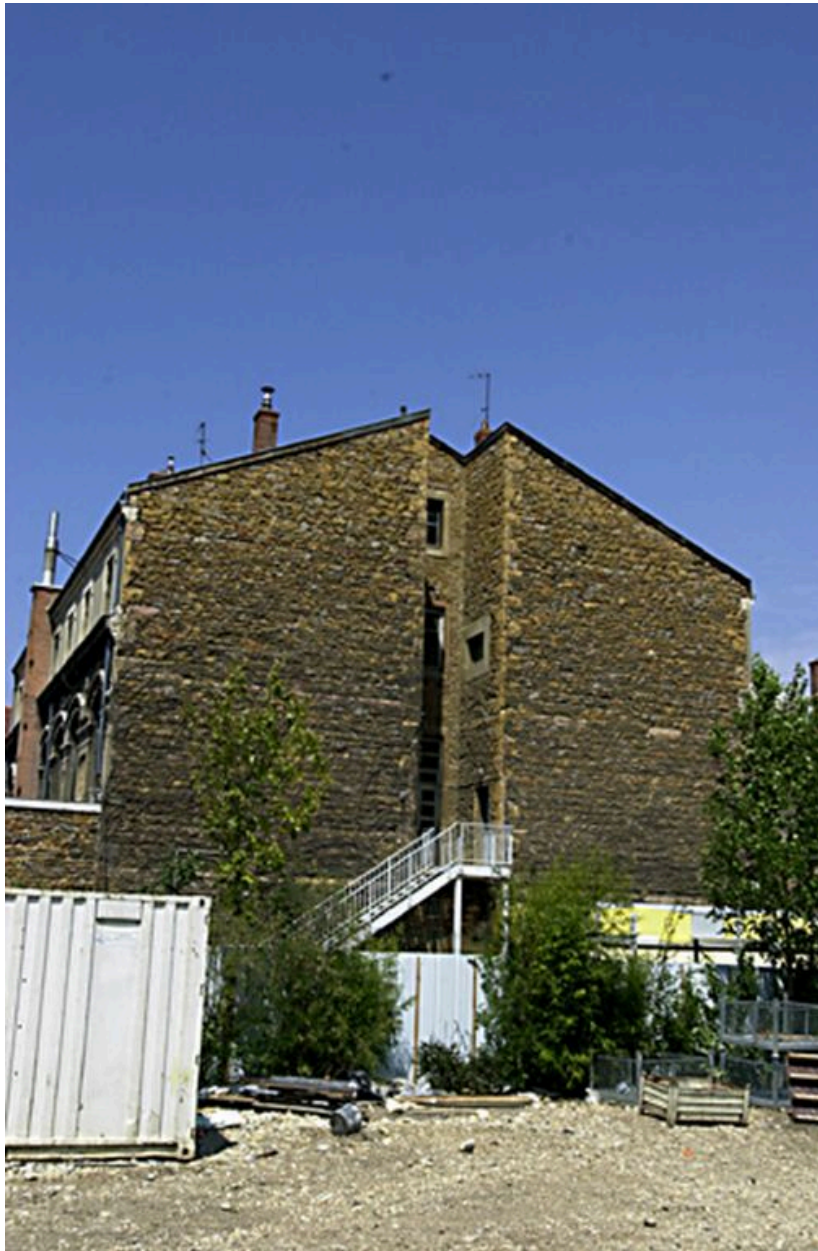
Elévation latérale est du bâtiment central
