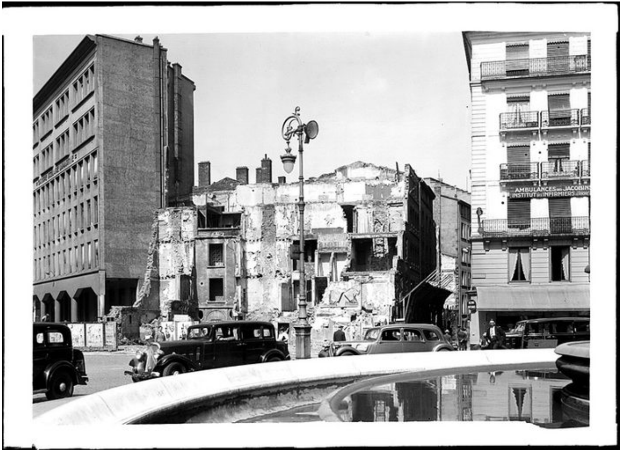
A droite, vue partielle de l'élévation place des Jacobins, 1937. fotogr. Nég. sur verre AM Lyon. 3 Ph 00237
