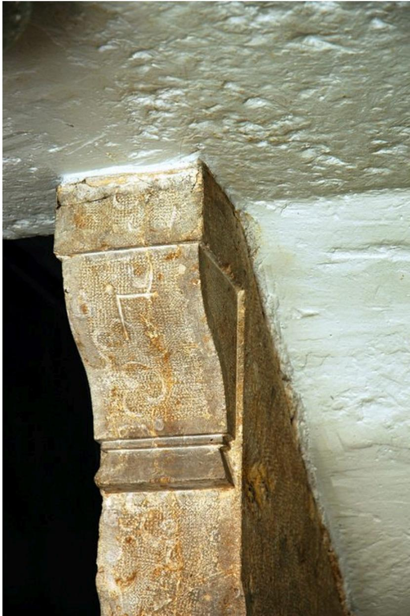
L'escalier : détail d'une console du mur-noyau
