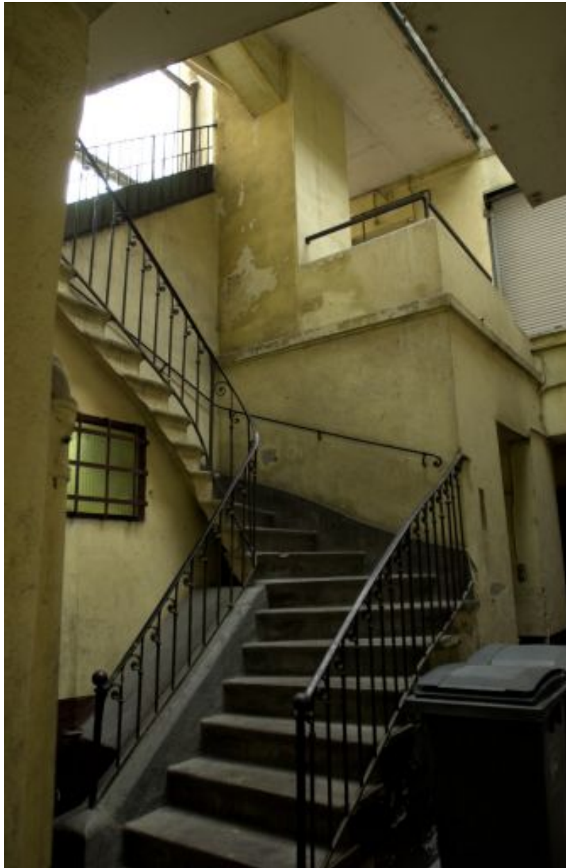
Vue de l'escalier central reliant les deux bâtiments
