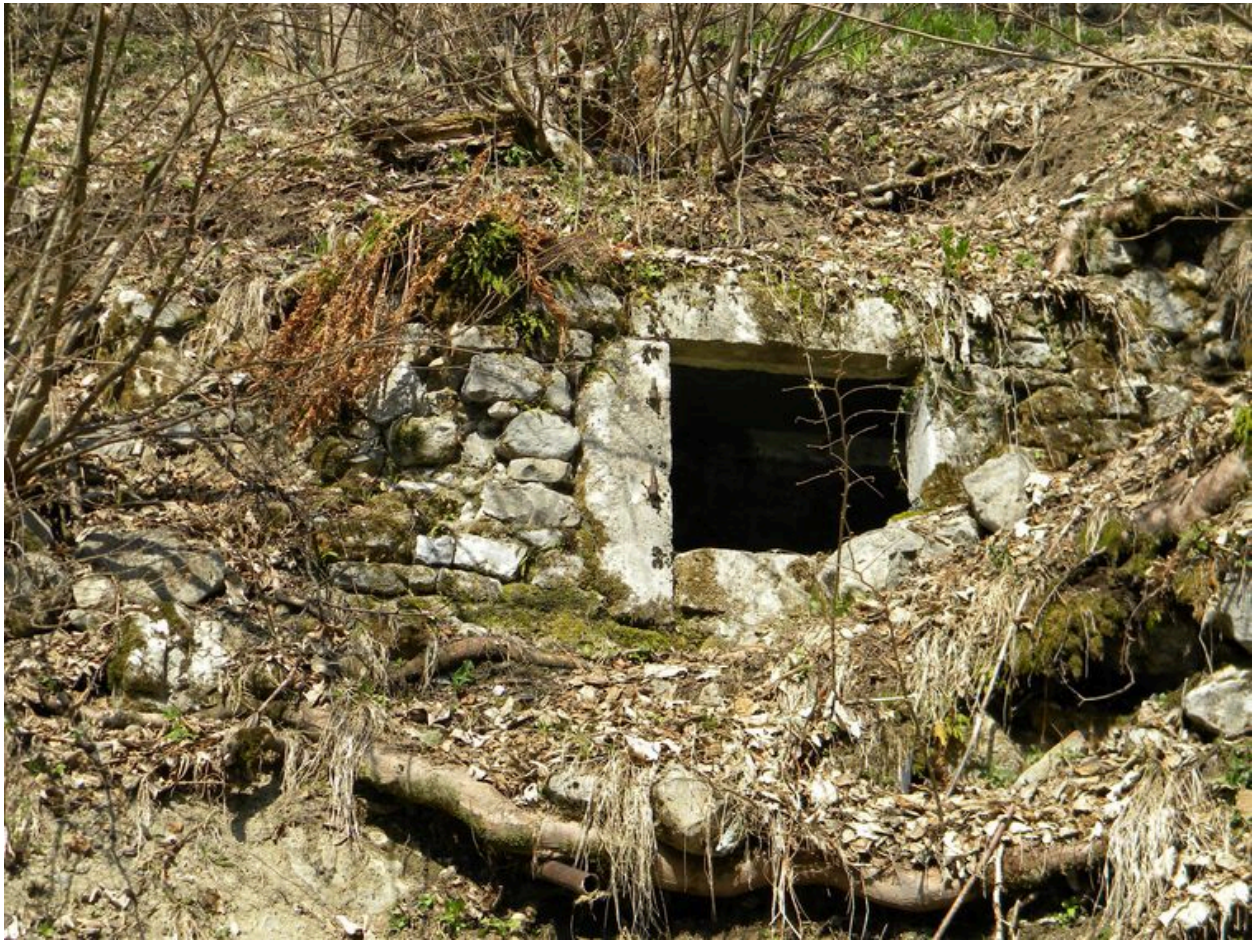
Vestiges d'une maison avec encadrement de fenêtre au-dessus du parking (2008 F12 1970)
