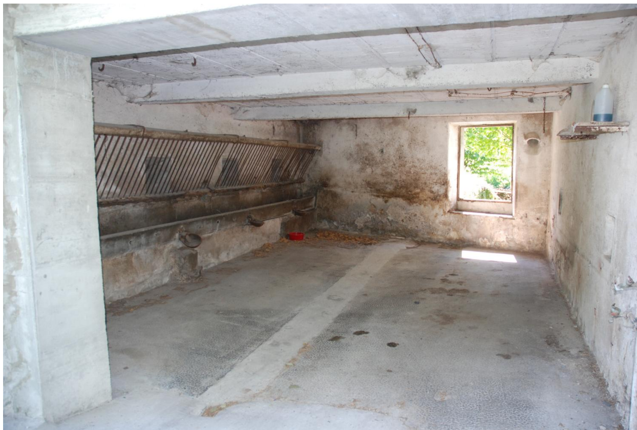
Grange-étable (2018 I1 198), vue intérieure de l'étable.
