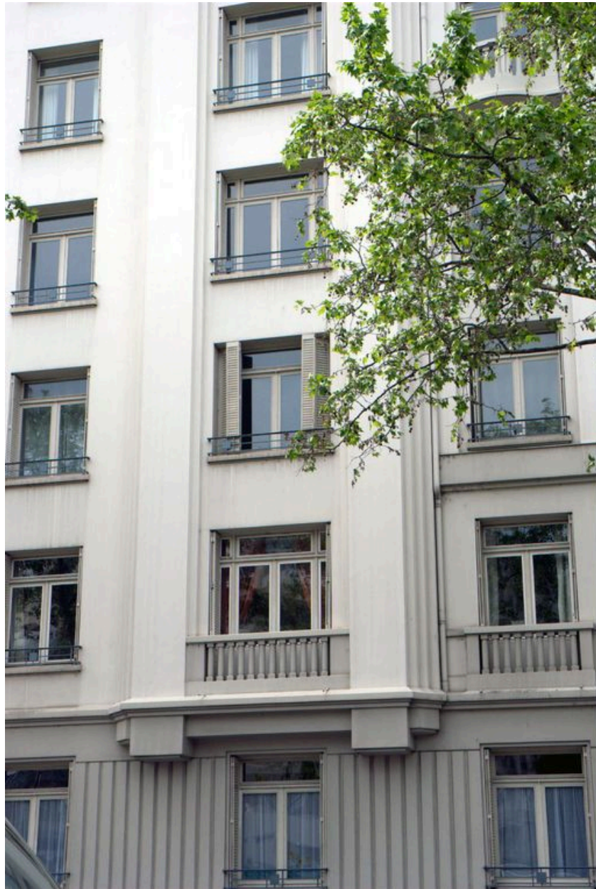
Elévation principale, détail d'une travée
