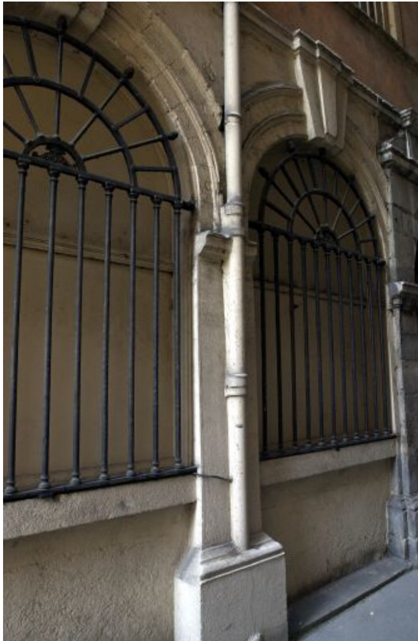
Façade principale, anciennes ouvertures de boutique
