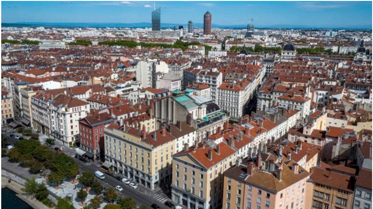
Vue aérienne partielle du secteur
