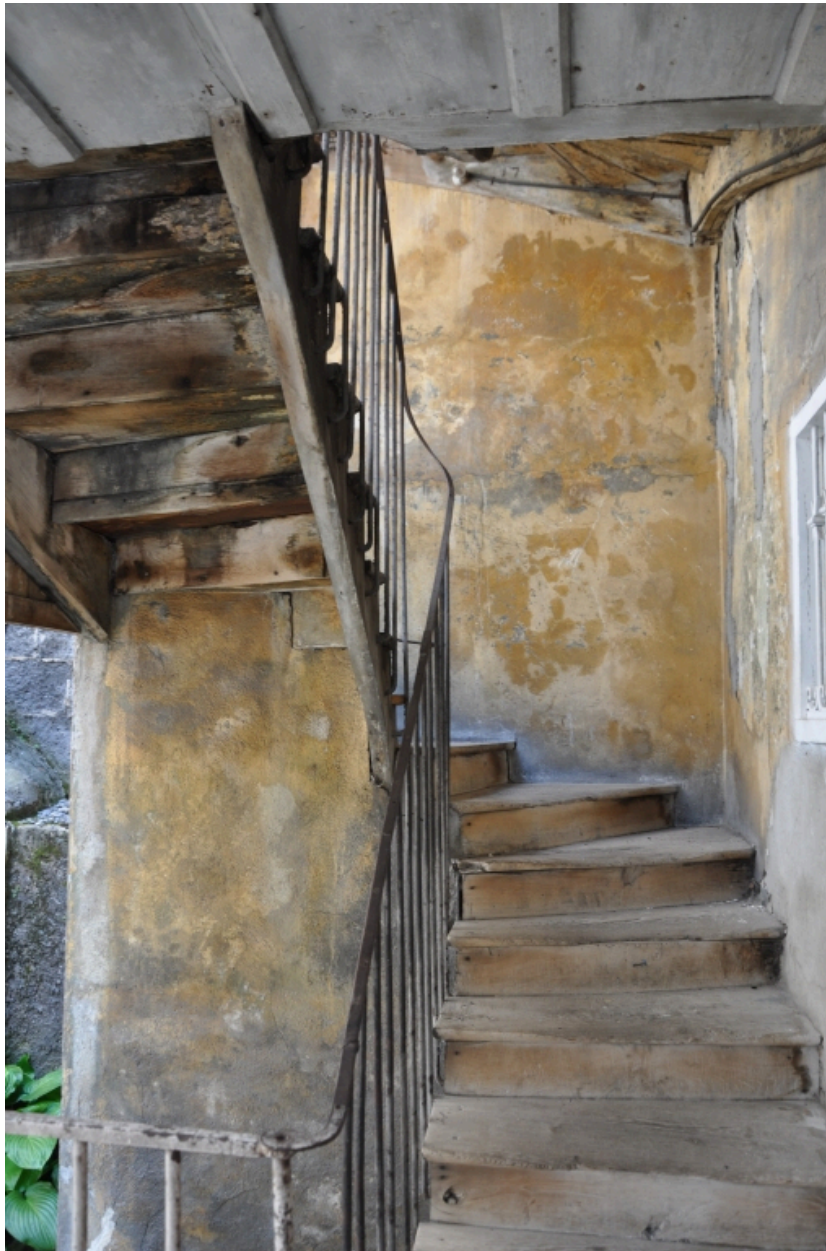
Détail de l'escalier extérieur
