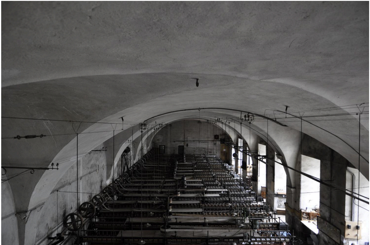
Détail plancher voûtes d'arêtes
