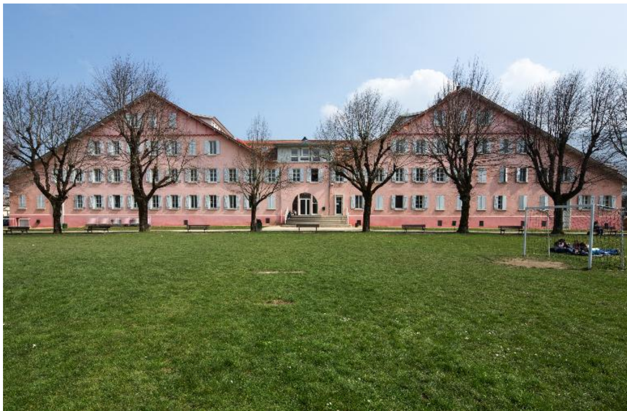
Bât. A : façade ouest de l'aile ouest
