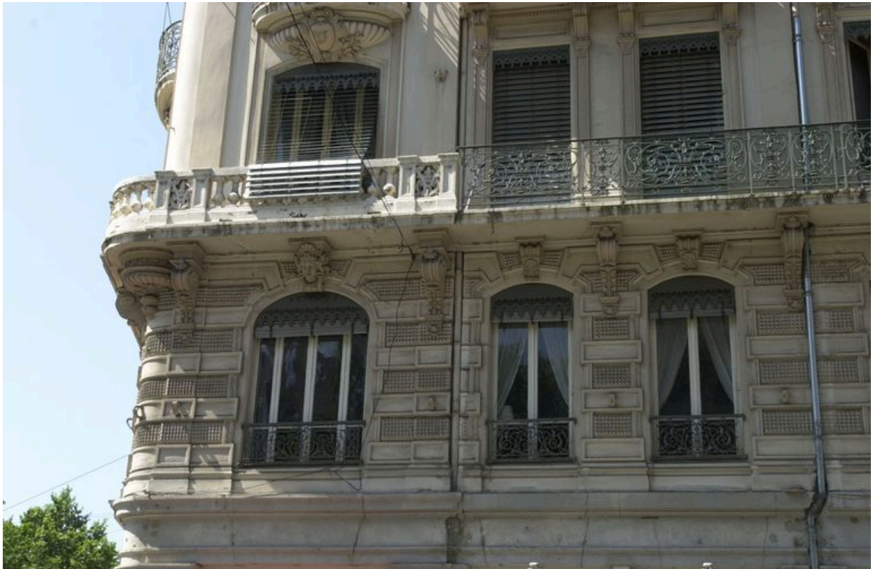
Détail de l'entresol, grande rue de la Guillotière
