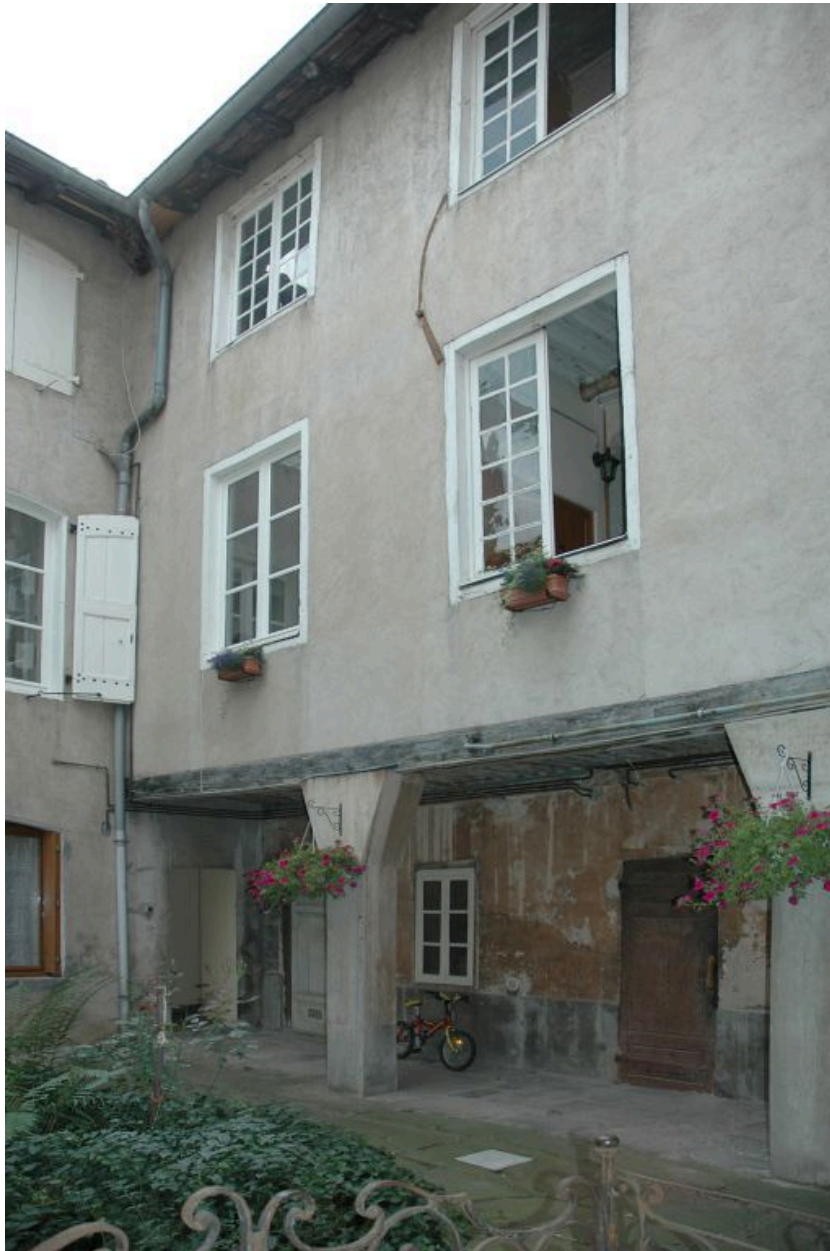
Immeuble de type 3 : corps de passage reliant les bâtiments sur rue et sur cour, plan en U.
