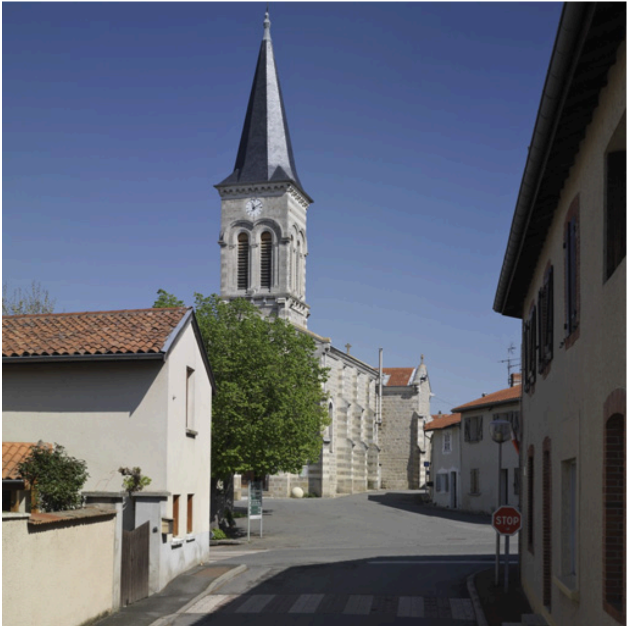
Vue d'ensemble de trois-quarts depuis le sud-ouest.
