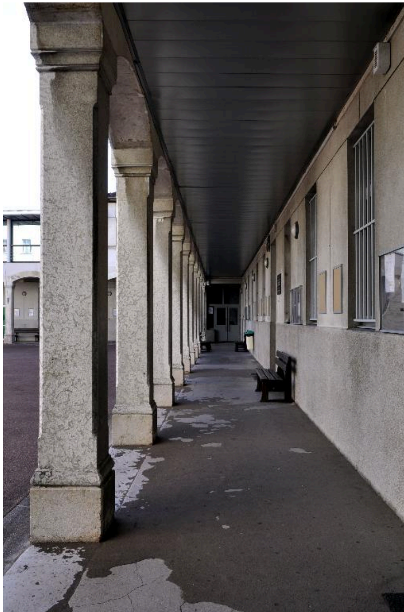
Galerie sur cour longeant le bâtiment A, depuis le nord-ouest
