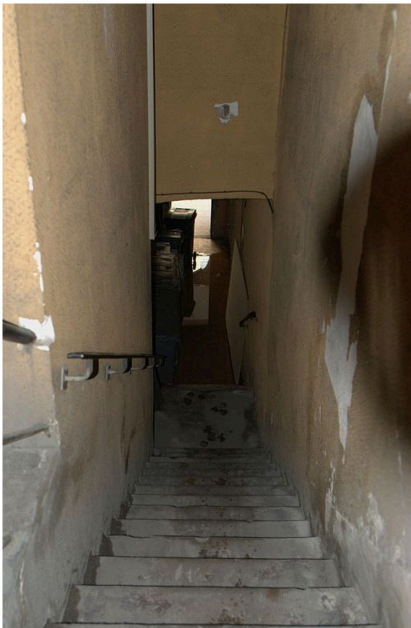
Escalier en équerre, vue de la 1ère volée depuis le haut
