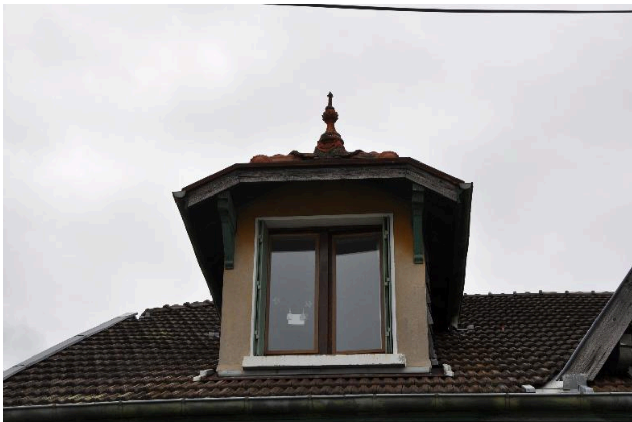
Détail de la lucarne sur le versant
