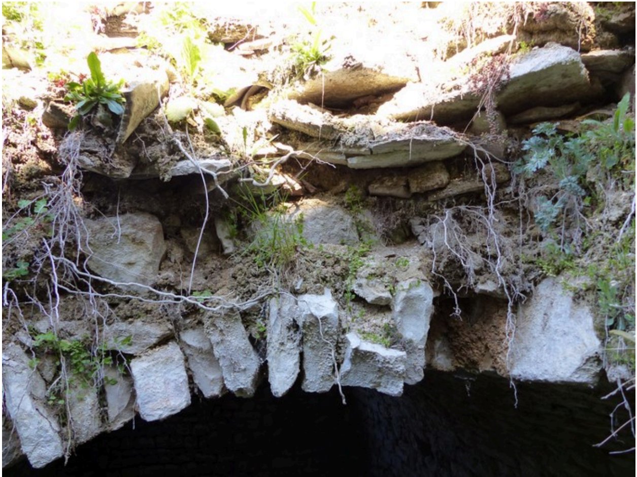
Sol en lauze sur l'extrados de la grande pièce nord-ouest.
