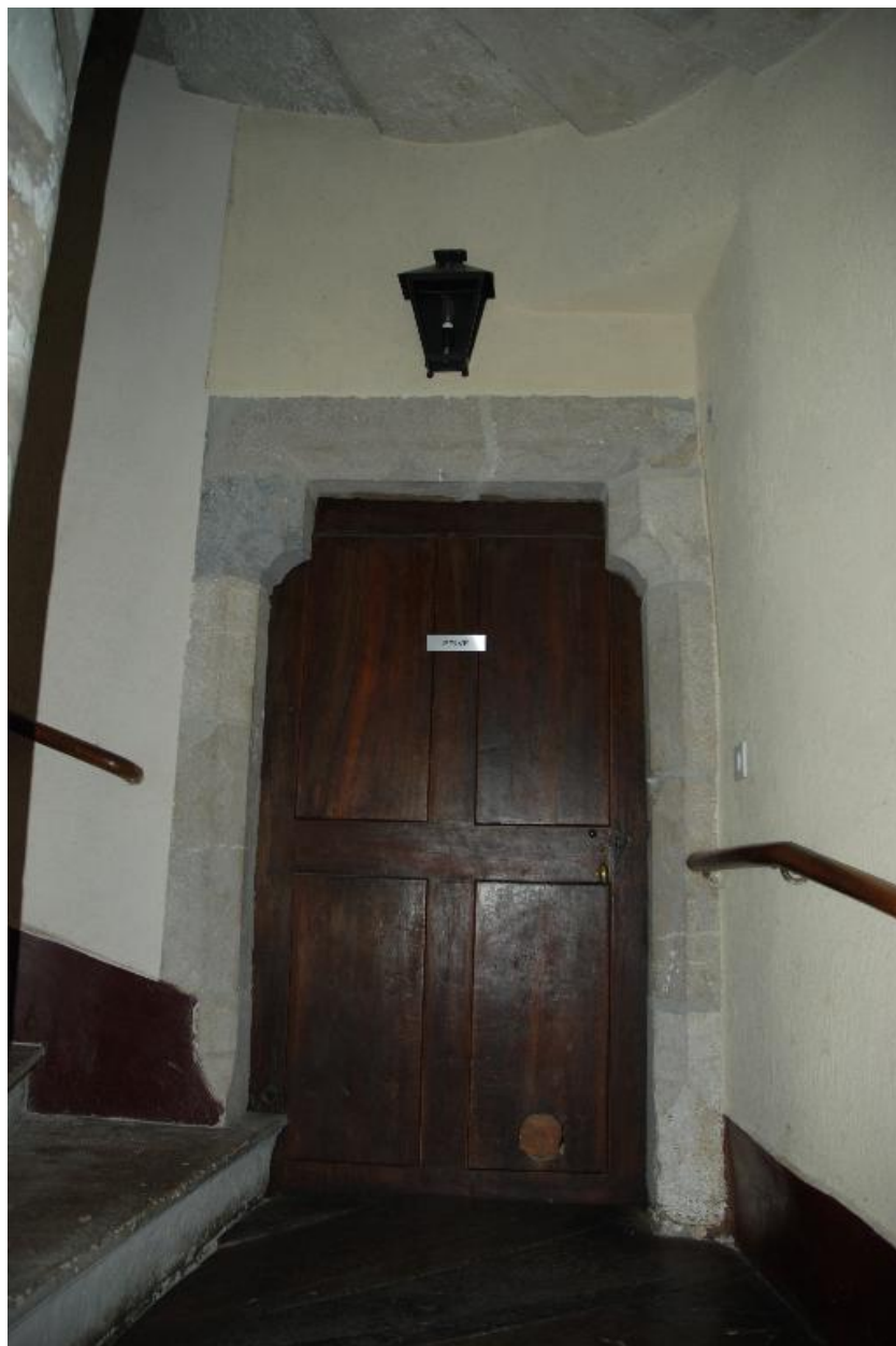
Escalier en vis. Porte du premier étage du corps de bâtiments nord/sud.
