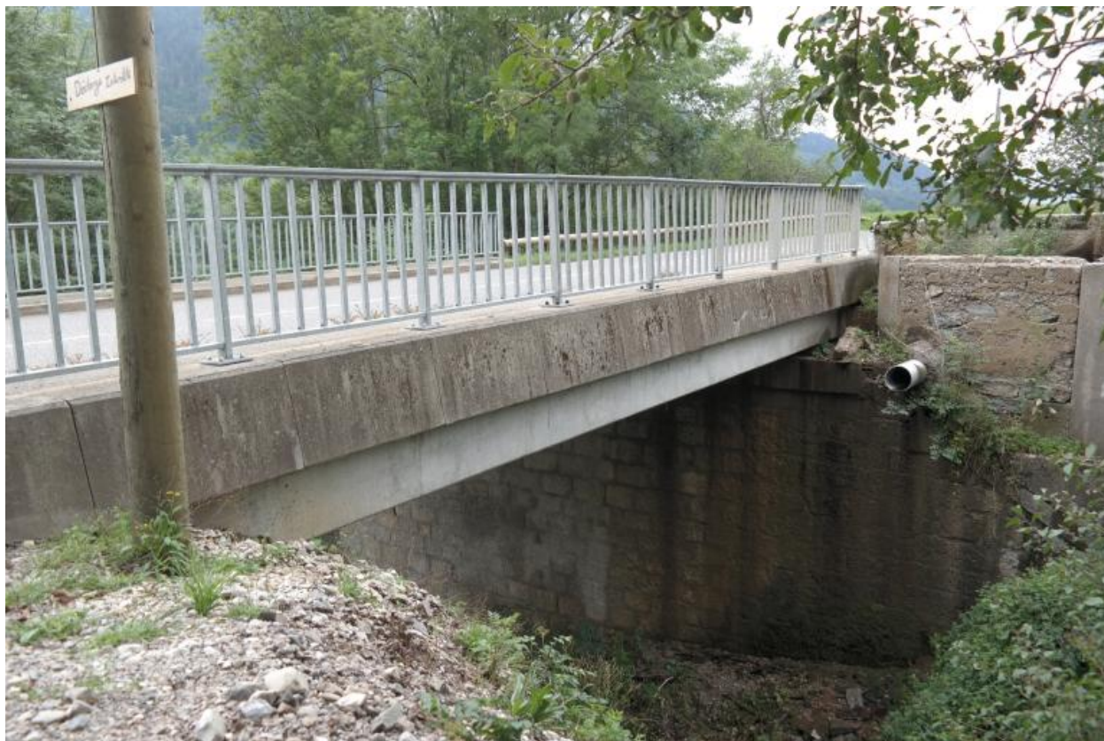
Pont d'Arce, vue de la face aval
