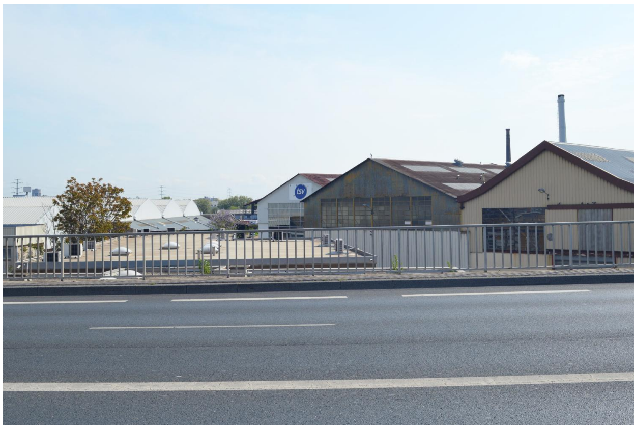
Aciéries de Longwy en 2022 vues depuis l'autopont
