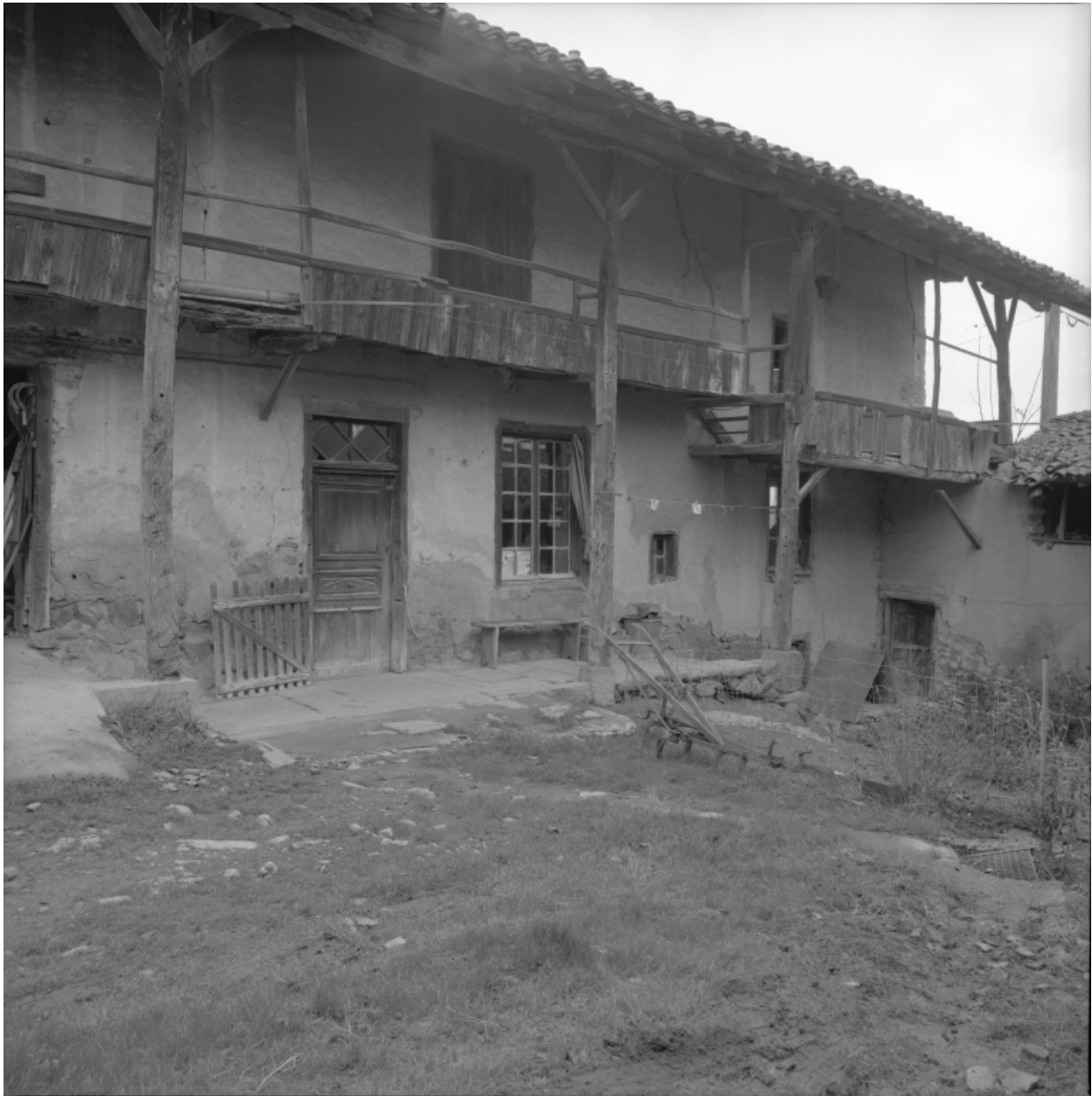
Vue d'ensemble du logis, élévation antérieure depuis la cour.
