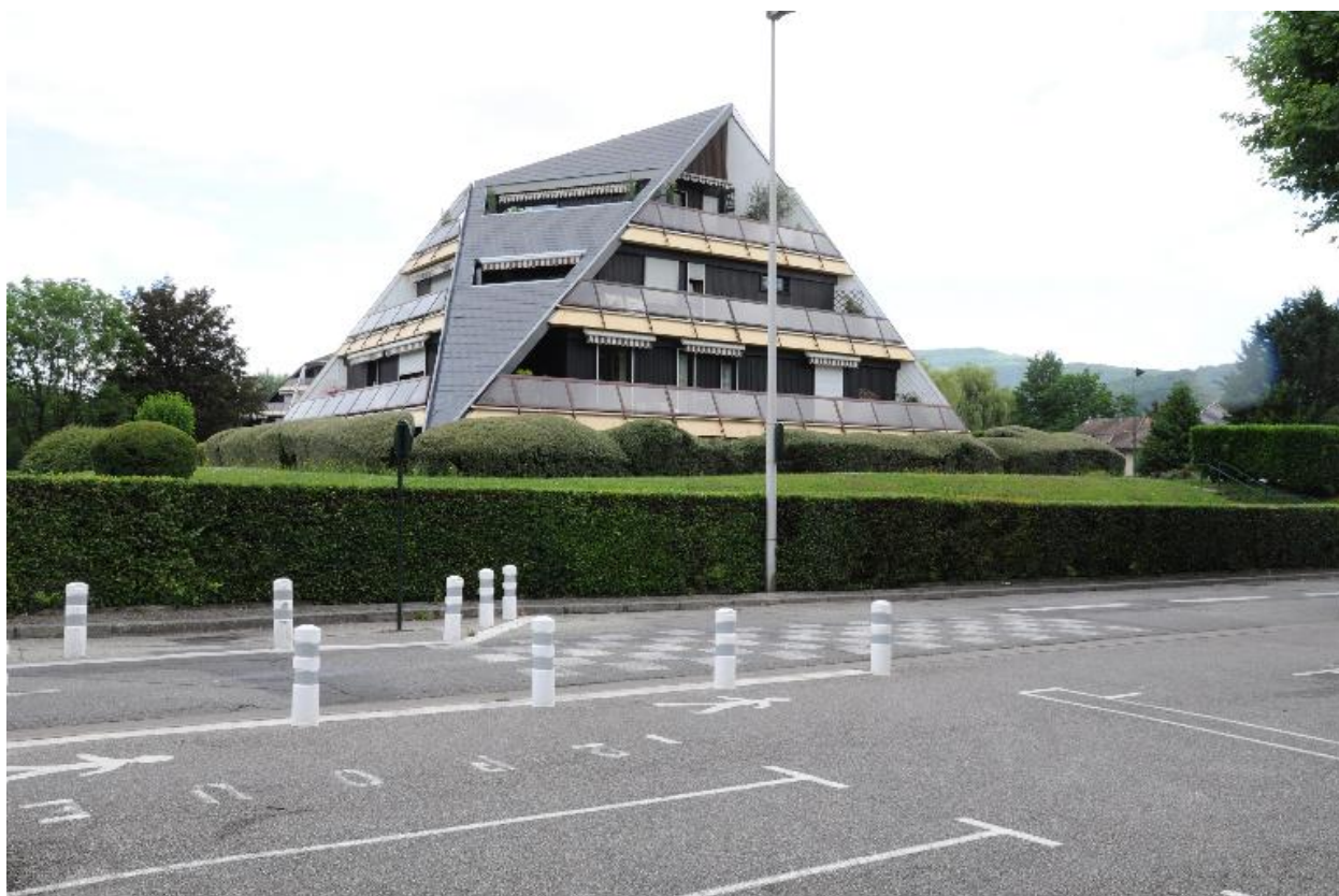
Pignon sud : immeuble Les Cygnes
