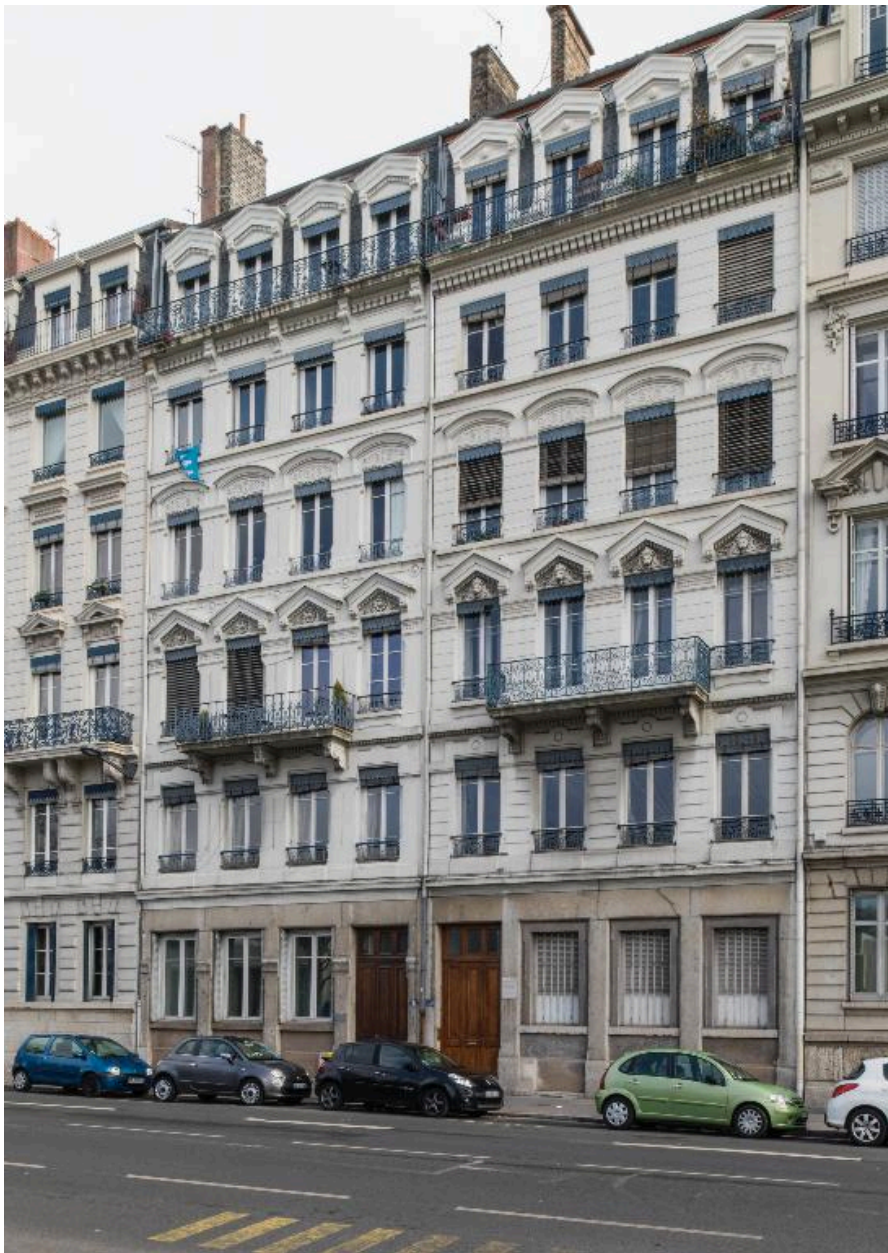
Vue générale des élévations sur quai
