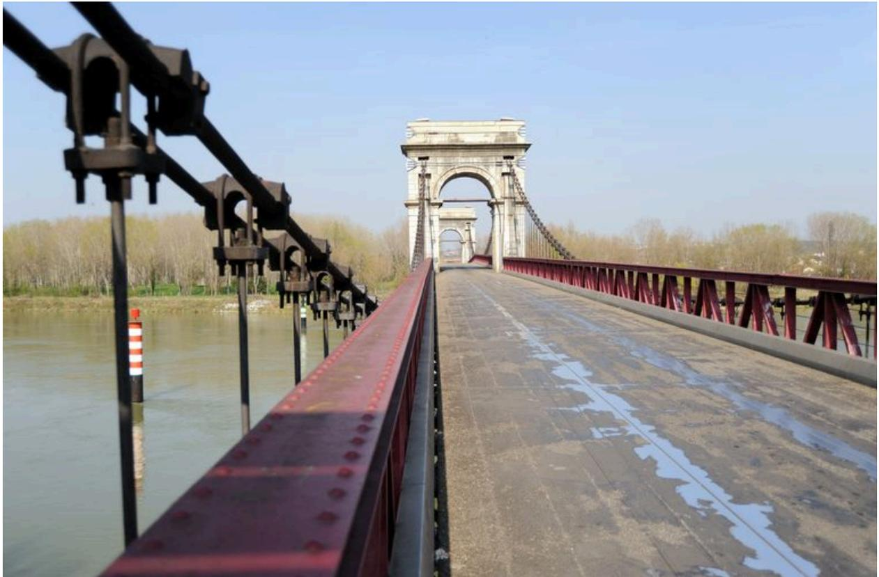
Vue partielle, de dessus, jonction des suspentes avec le câble porteur, parapet (depuis la rive droite)
