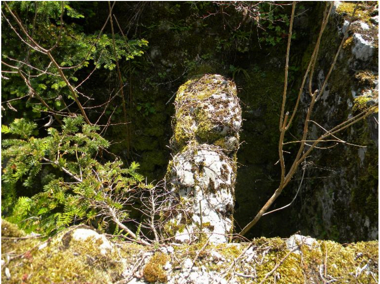
Vue de l'arche sur une sorte d'évacuation.
