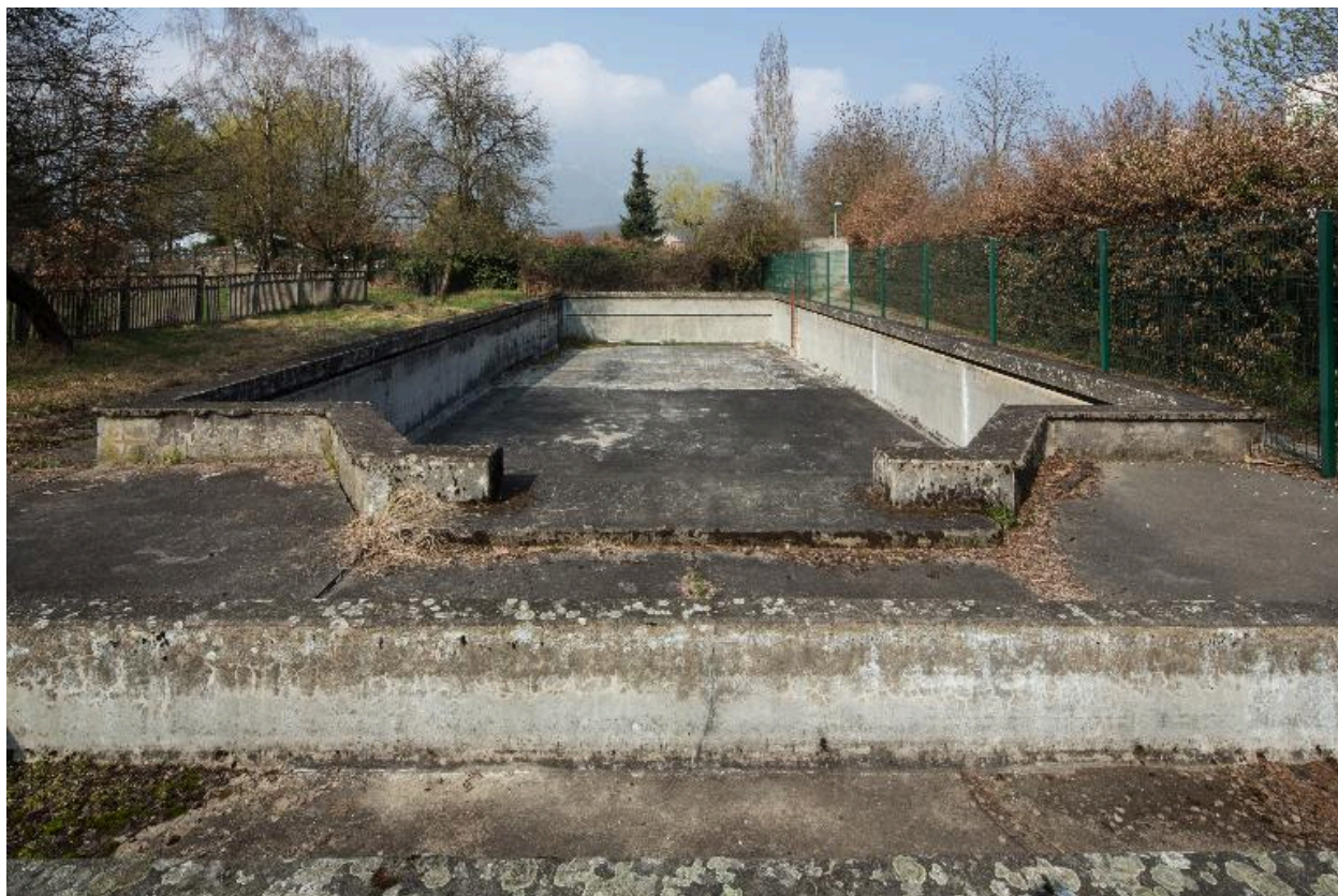
Piscine : vue d'ensemble
