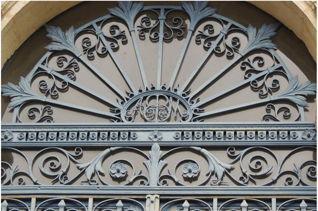
Façade ouest, imposte des grilles : détail.
