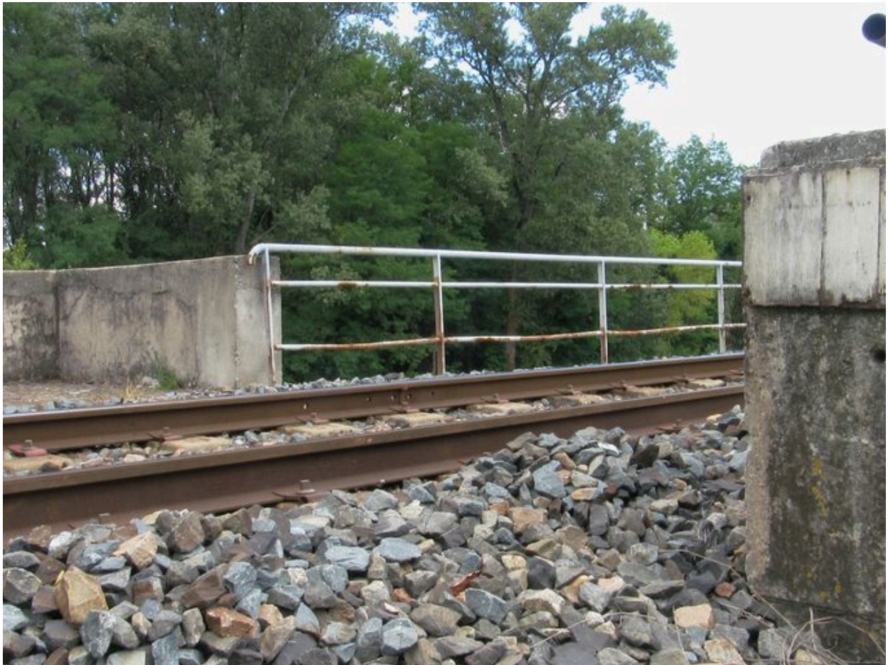
Vue sur la voie ferrée
