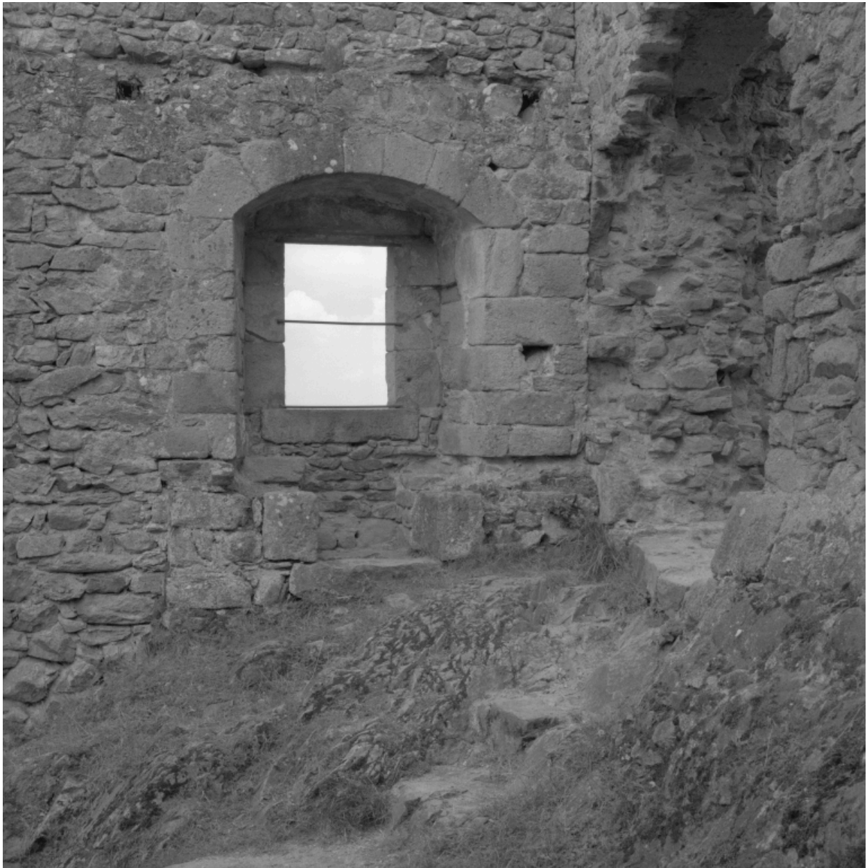
Ouvrage avancé du château fort primitif : détail d'une fenêtre à coussièges, du nord-est.
