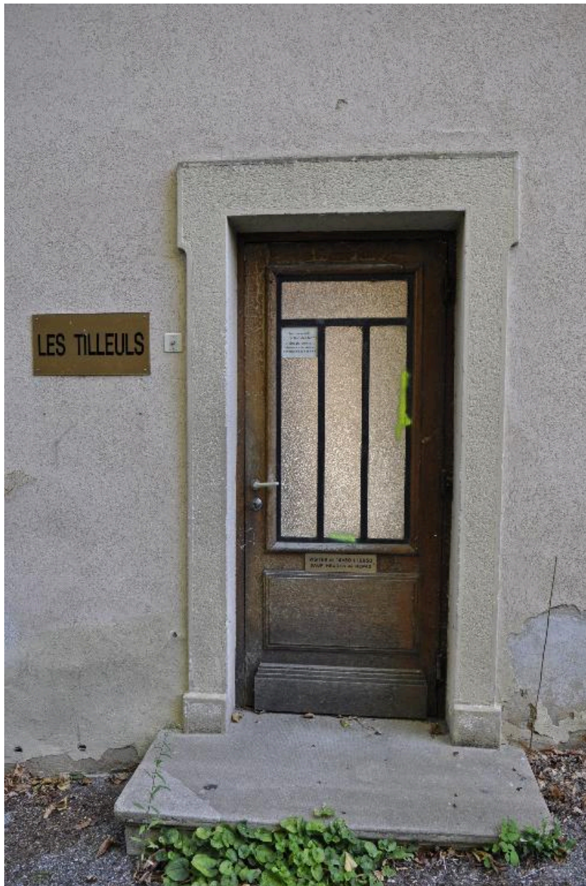
Second corps de liaison, élévation ouest : vue de la porte
