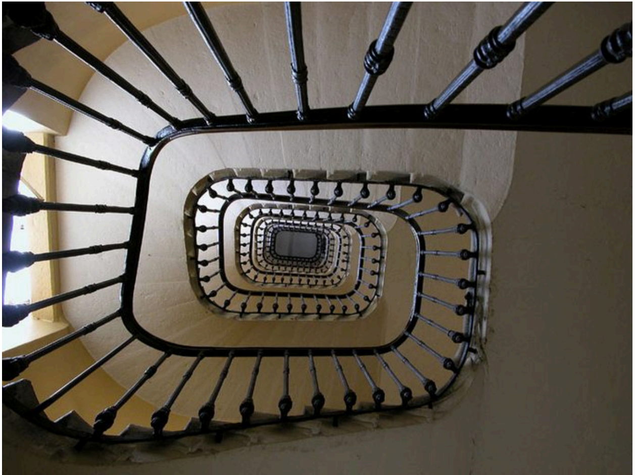
La cage d'escalier en contre-plongée
