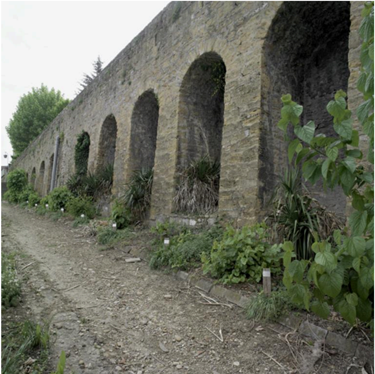
Collection de mûriers le long du mur de soutènement contrefort de la terrasse du bâtiment principal.
